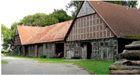
EIN TEIL DER HOFANLAGE MEYER ZU JERRENDORF
